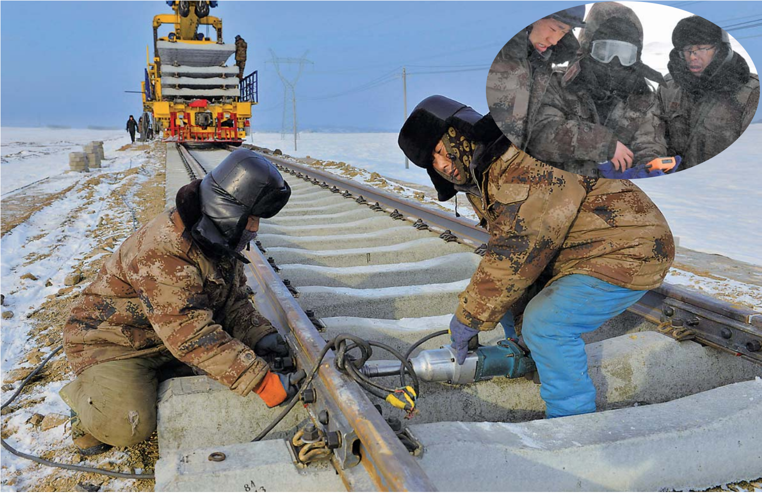
小图：负责技术测量的工人在测量风速，观察现场是否符合施工条件（1月31日摄）。 大图：在玛依塔斯施工现场，工人们在打卡子固定轨道（1月25日摄）。 新华社记者孙少雄摄 新华社发（李建锋摄）
